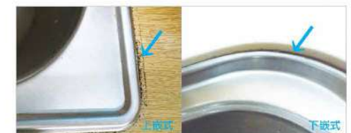
一般水槽與台面接合處，因為有細縫容易藏污納垢，無法清潔。
